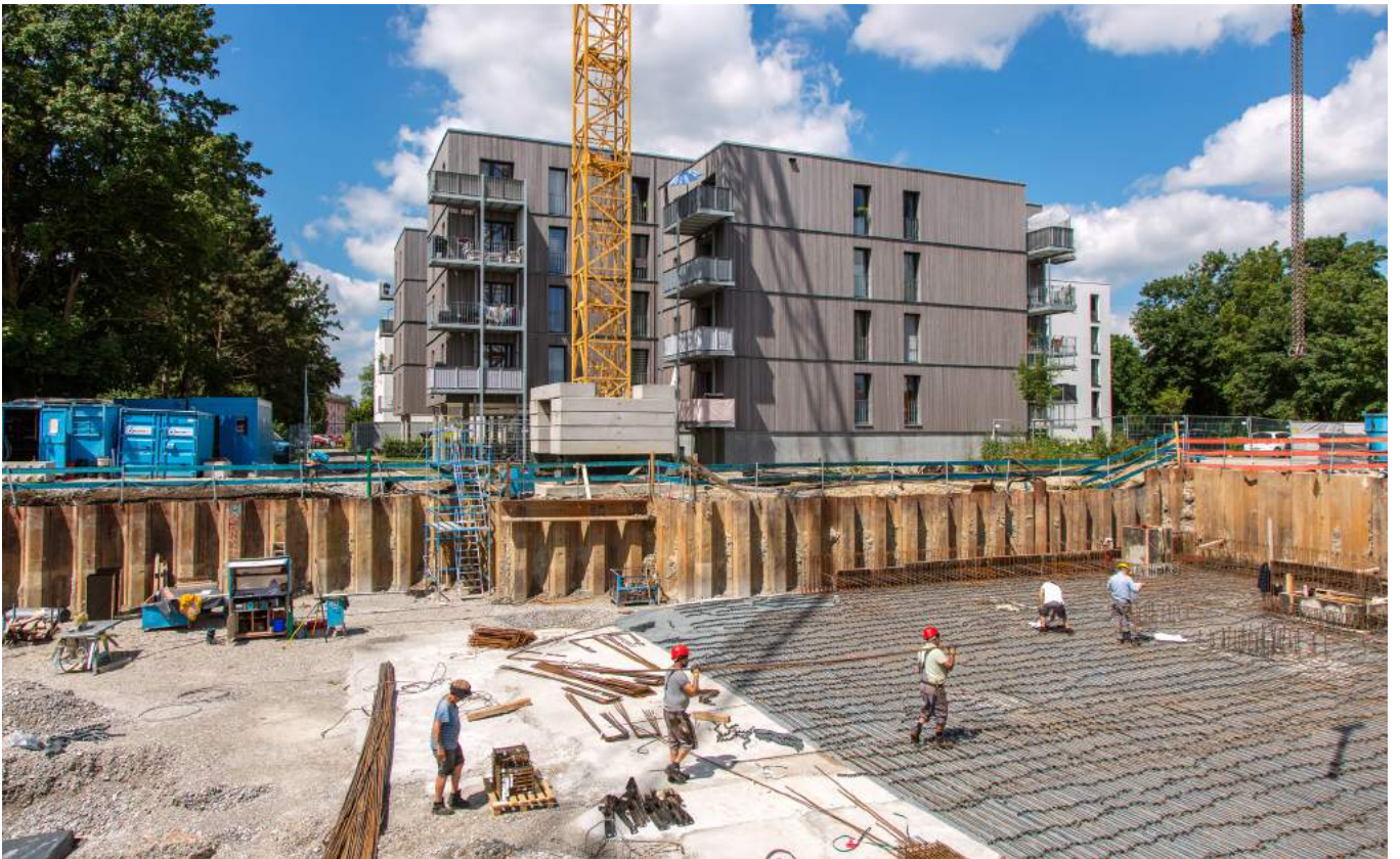
Neubau Münsterblickstraße Bauabschnitt 3
